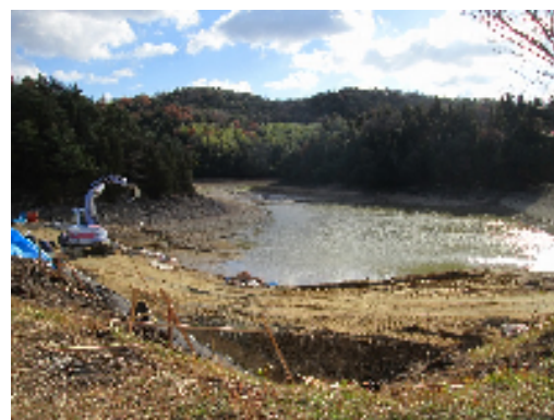
萬浦池の護岸工事 池の水抜き作業
