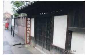
平賀源内の旧宅
